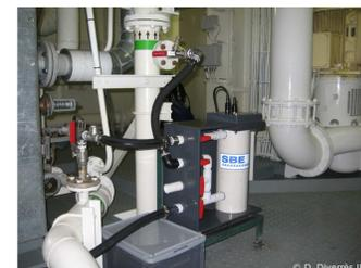
Figure 2. Thermosalinographe en salle des machines.
